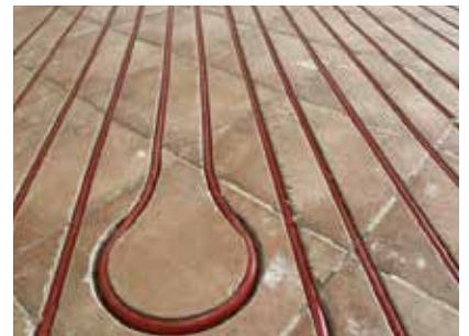
Fresatura su pavimentazione preesistente
