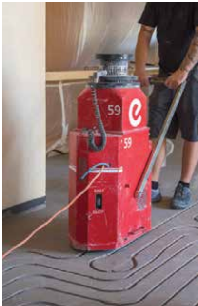
Fresatura su pavimentazione preesistente
